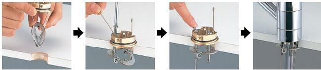
ユニット上面から施工できるので、シンクの下にもぐり込まず立ったままでの簡単・ラクラクな施工ができます。
